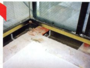
取替サッシ充てん前
