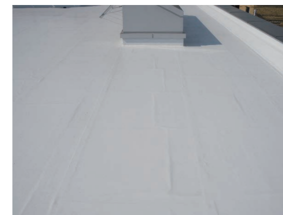
断熱材の段差
