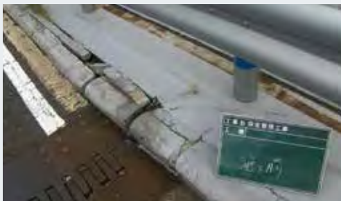
都市高速道路での施工例
