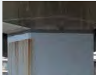
国道での施工例
