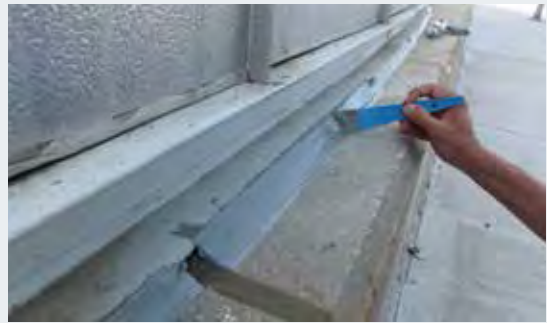
施工中 (シリコーンスポンジのバックアップとシーラントマスター300を用いてスロープ付け:施工断面略図参照)
