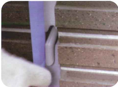
④上部にバックアップの設置
