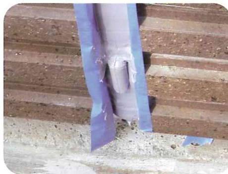
⑤目地のシーリング仕上げ
